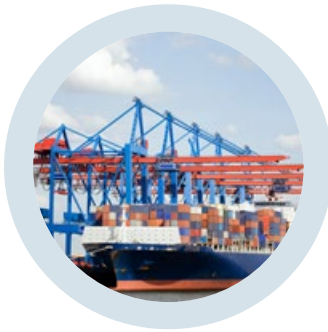
Control de puertos
